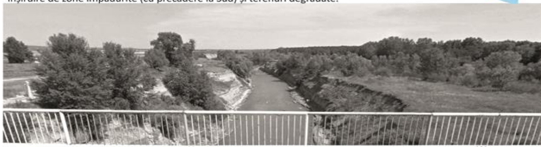
Lucrările de regularizare mai ample și exploatațiile în mal au determinat modificarea volumului de apă și al sedimentelor, generând un profilul adâncit al albiei. În lipsa unei vegetatii ripariene consistente integritatea malurilor este periclitată de eroziune.
