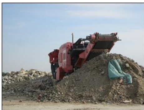
Foto 9 Platforma depozitare/concasare deseuri
