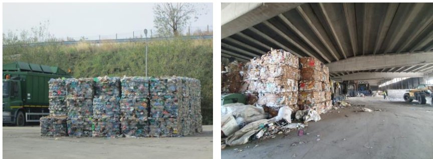
Foto 6 Platforma depozitare baloți deșeuri de plastic și deșeuri carton + hartie
